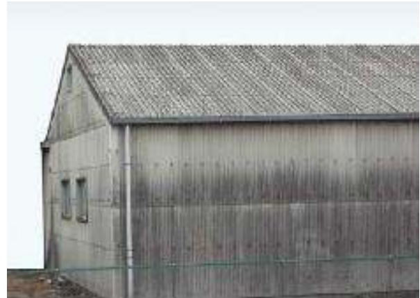
石綿含有スレート波板（屋根・外壁）
